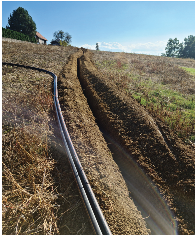
Gradnja optičnega omrežja
