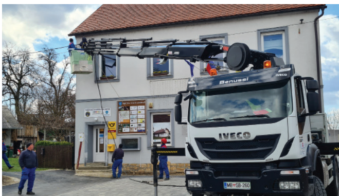
Elektro Maribor položil elektriko v tla
